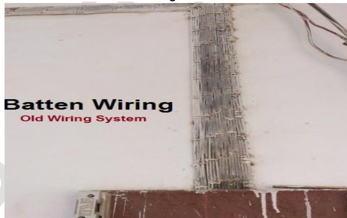
(Fig.5.3. Batten Wiring)
